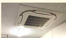
↑廊下の天井にも エアコン設置
